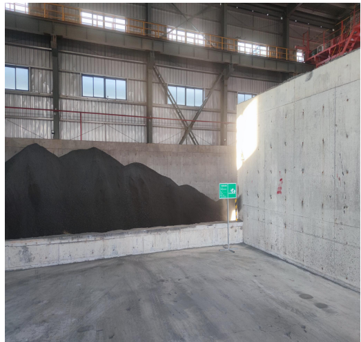
一般固体废物暂存库
