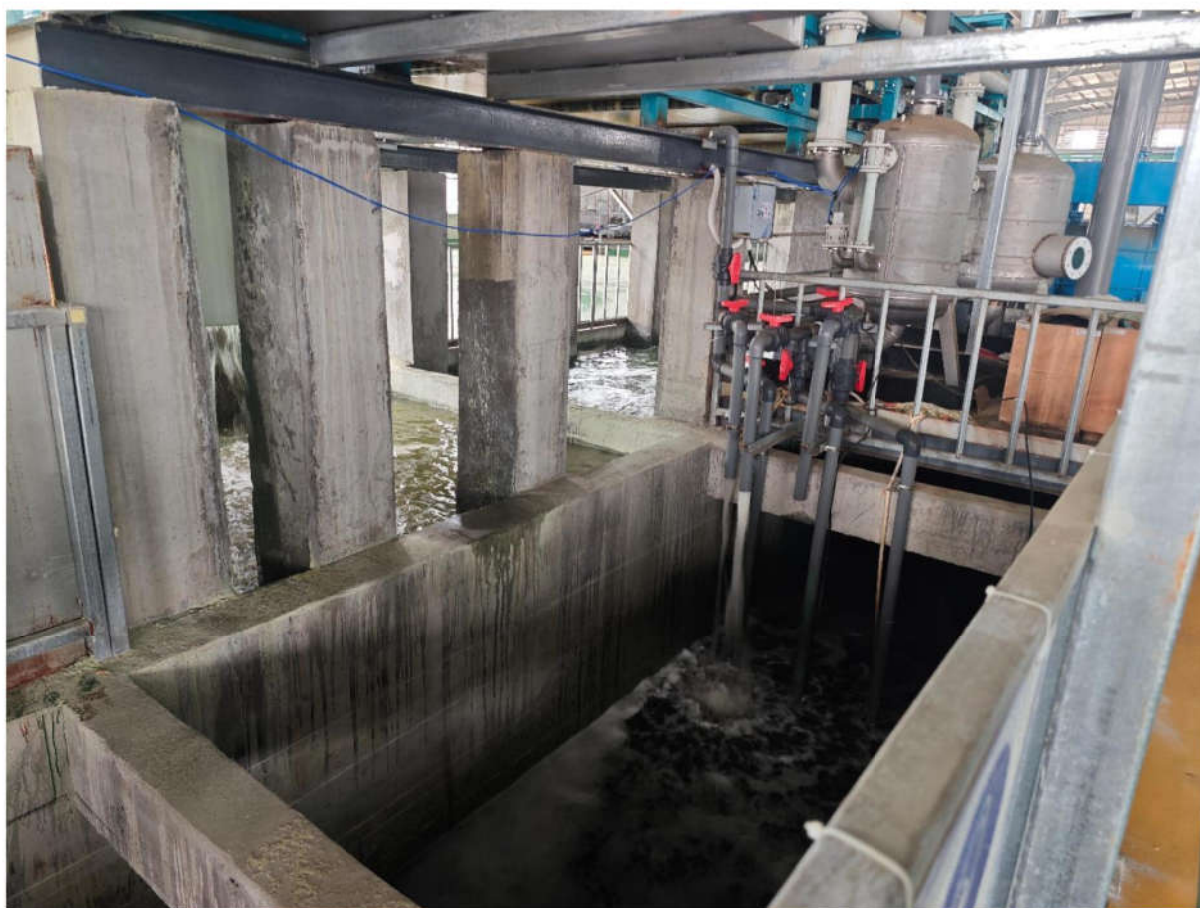
图 4.2-4 项目沉淀循环水池现场图片
