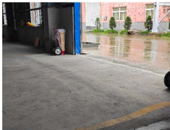
生产车间出入口漫坡 (2)
