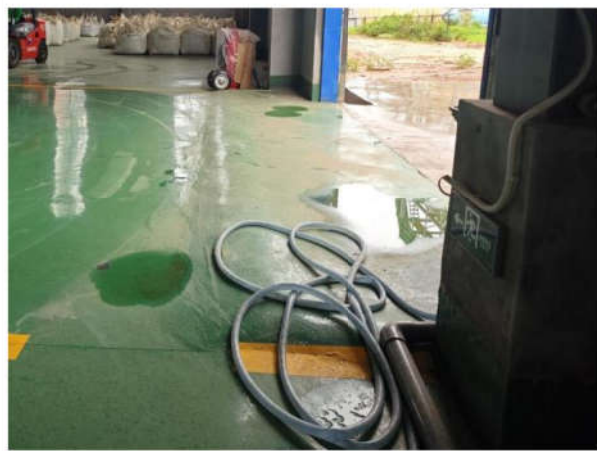
生产车间出入口漫坡 (1)
