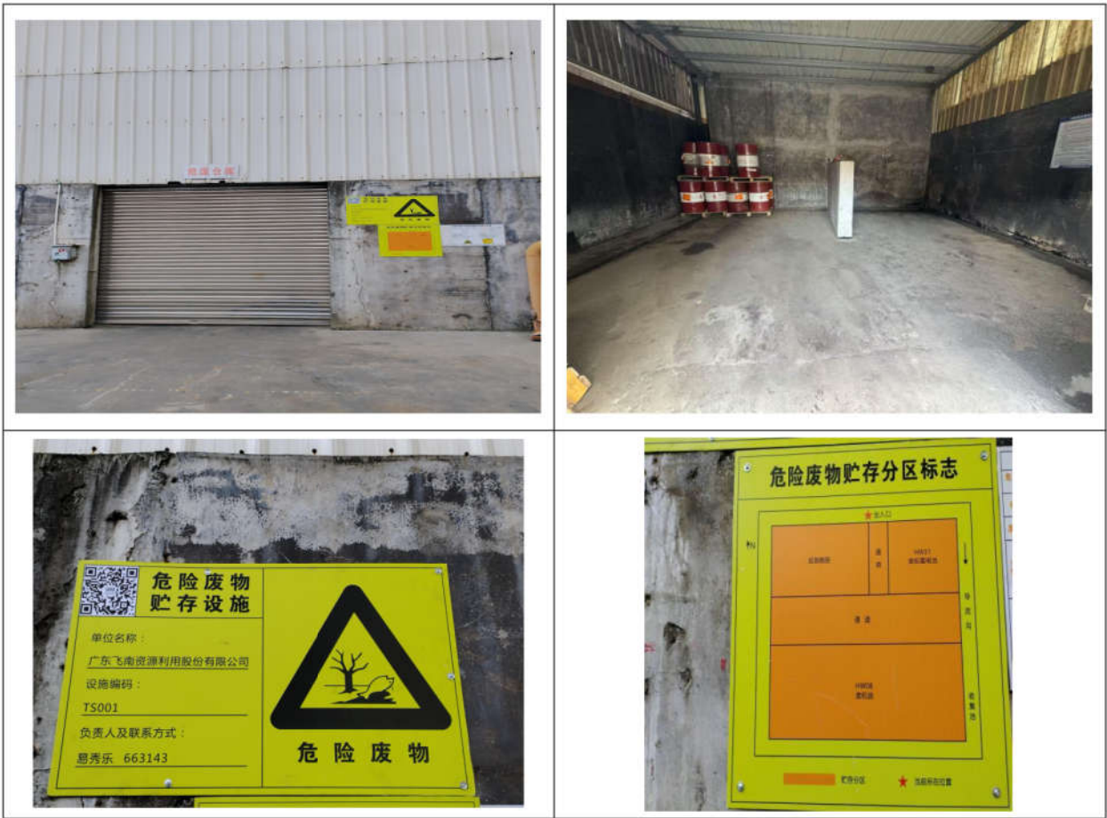
图 3.6-2 机修含油废物暂存位置现场照片
